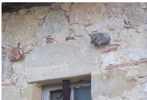
Une curiosité de la part des maçons, deux mains incrustées dans la pierre
