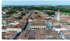
Travaux en centre-ville
