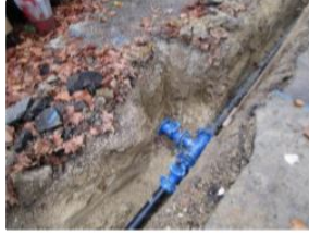
Modernisation du réseau d'eau potable
