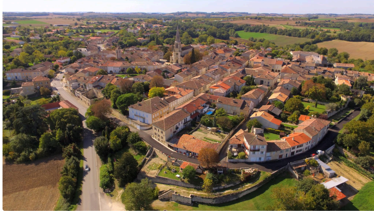
Arrêté du 17 septembre 2018 portant reconnaissance de l'état de catastrophe naturelle
