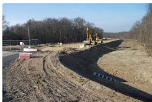
RN 124, contournement de Gimont : Le chantier va redémarrer et devrait être achevé en 2021
