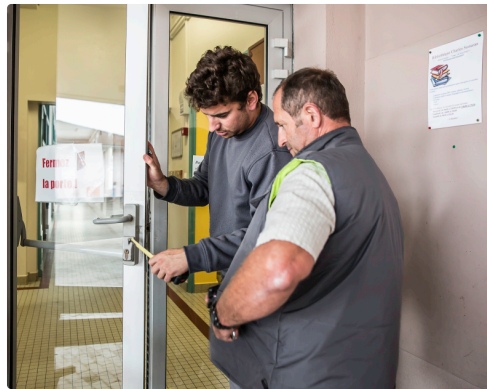
Les services techniques de la commune remettent la porte d'entrée en état
