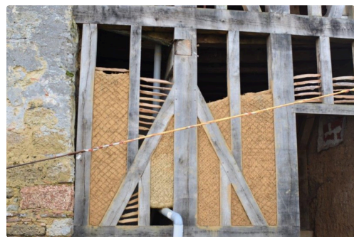
Le torchis sur la façade nord du Castet - Photo communiquée par la mairie de Sainte-Christie-d'Armagnac
