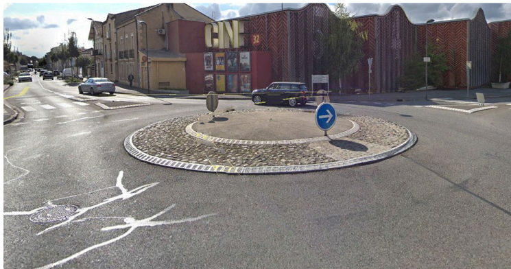
Travaux : circulation perturbée
