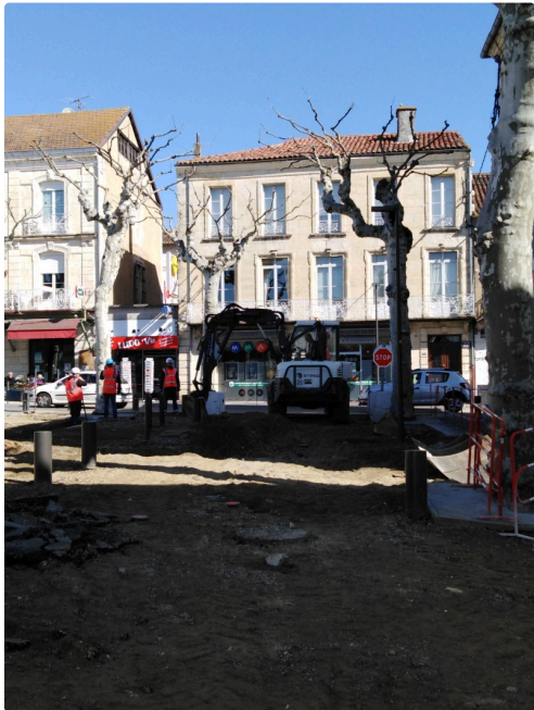
Travaux au centre ville
