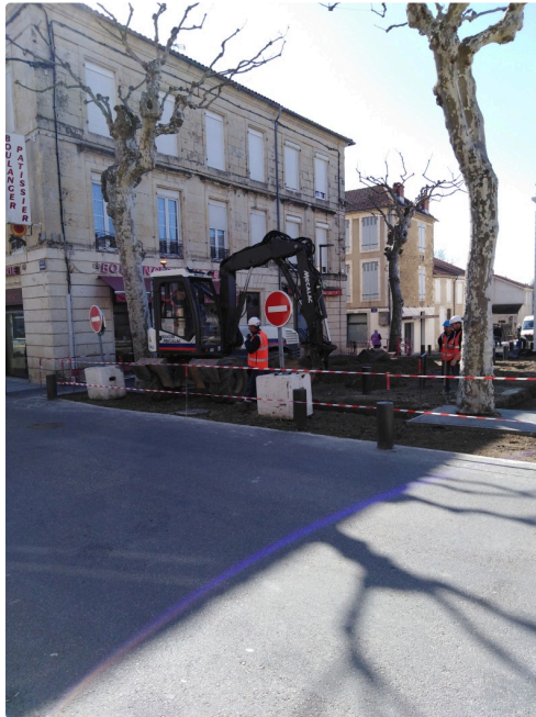
Travaux au centre ville
