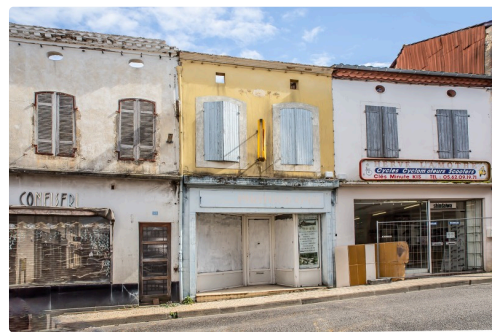
Seules les façades subsistent le 4 avril (on voit à travers les œils-de-boeuf)
