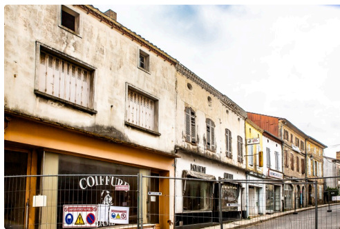
Avant la démolition, le 3 avril
