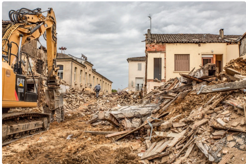
De la rue du Four, on voit la mairie et, à droite, le 3ème bâtiment à détruire
