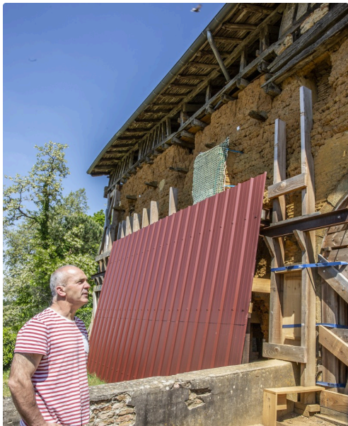
Les énormes protections du rempart avec cavité en bas
