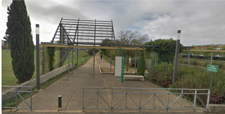
Travaux sur la promenade le long du Gers
