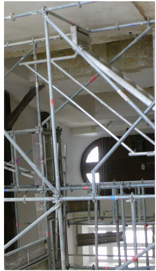
Des travaux impressionnants.
