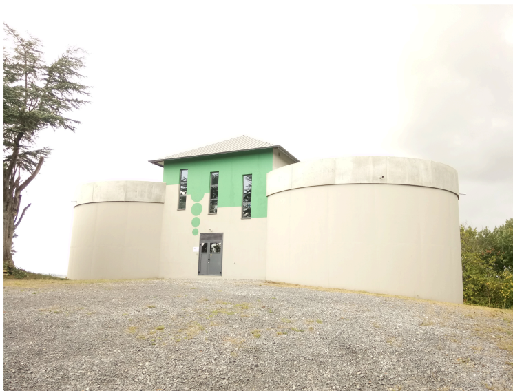
Eau Potable du Siebag : perturbations possibles dans la distribution
