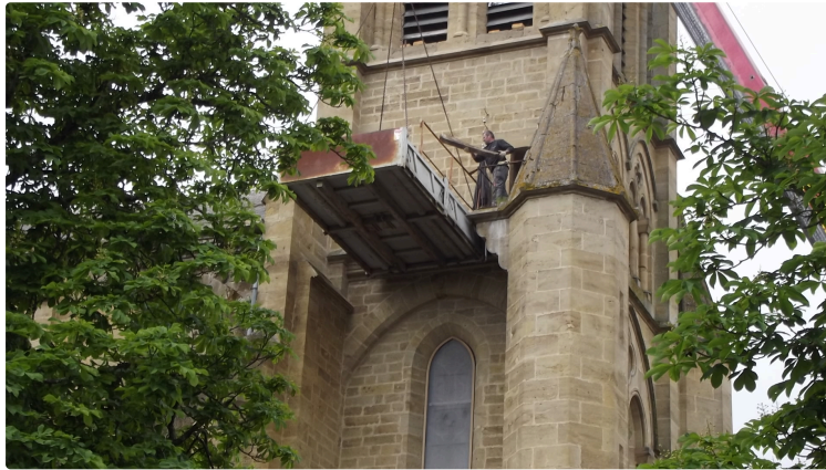
Poursuite des travaux à l'église
