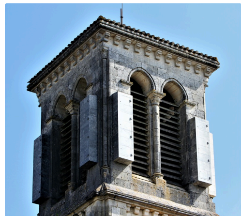
Malgré l'intervention d'un artiste peintre pour tenter un camouflage, ça ne passe pas du tout inaperçu.
