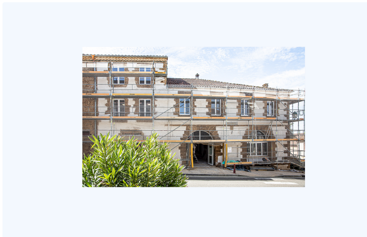
Des travaux qui font du Houga une belle entrée dans le Gers
