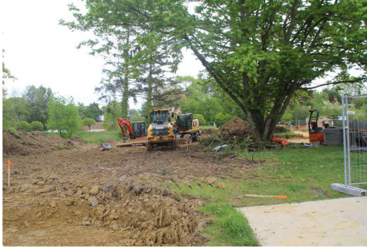
Les travaux des parkings sont en cours
