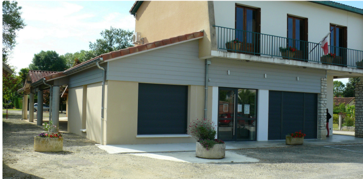
Un cycle de travaux s'achève, ils viennent d'être inaugurés
