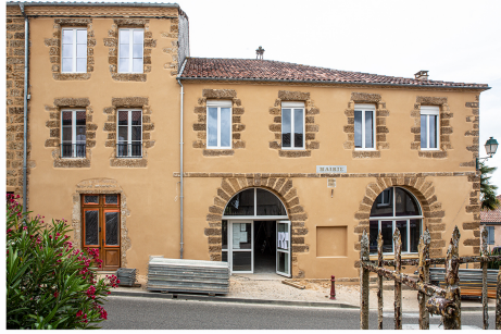
Mairie du Houga : les travaux se terminent
