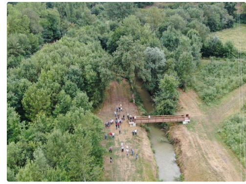
La passerelle vue du ciel...une intégration paysagère réussie
