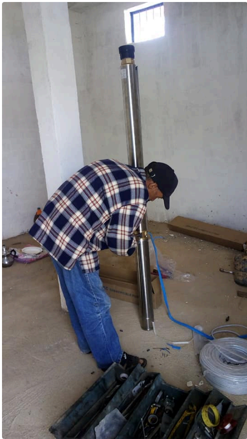
Installation de la pompe de forage
