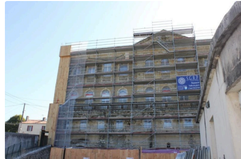
La façade Polignac, en travaux
