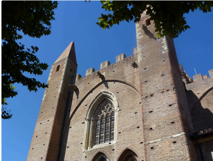
L'antenne de la discorde
