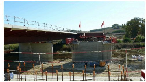
Le pilier prêt à recevoir le tablier Auch-Toulouse.
