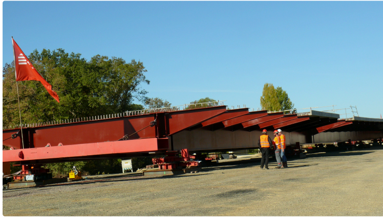
Déviations de Gimont : fin des travaux 2022
