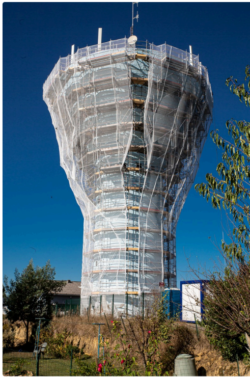
1 Le château d'eau sous échafaudage 1bis 111019.jpg
