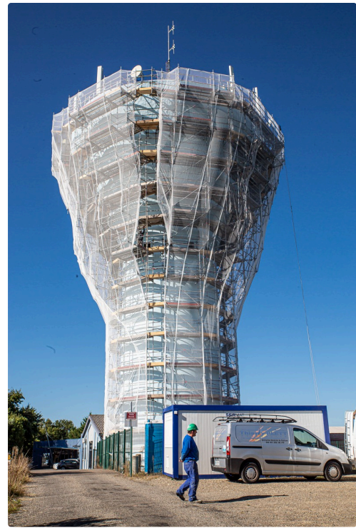
3 Le château d'eau sous échafaudage 1bis 111019.jpg
