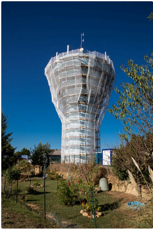
2Le château d'eau sous échafaudage 1bis 111019.jpg
