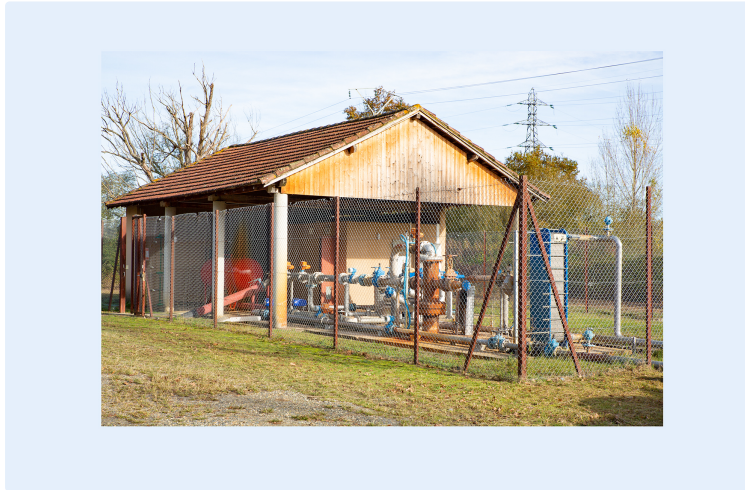
Géothermie à Nogaro en préservant la ressource en eau
