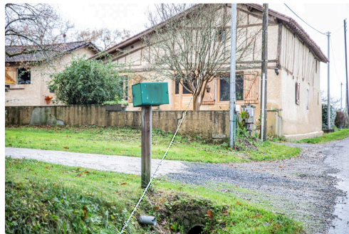
Câble téléphonique à terre entre 4 poteaux
