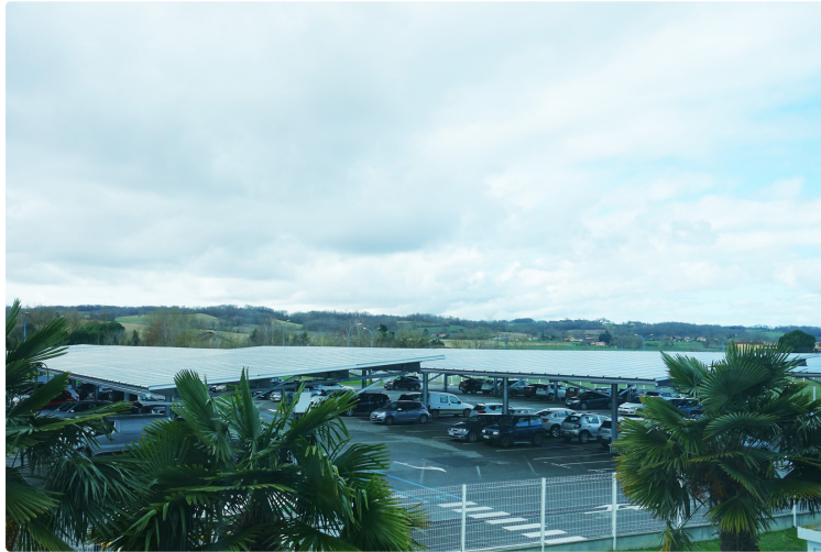
L'usine de Danone Villecomtal-sur-Arros s'équipe d'ombrières photovoltaïques avec EDF
