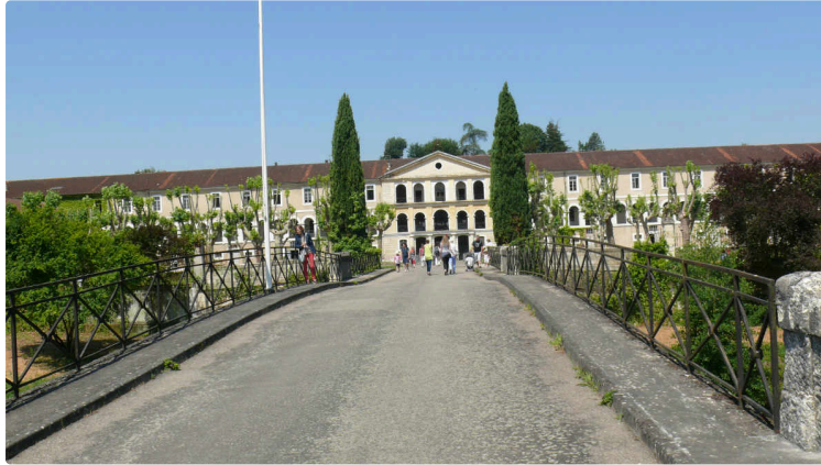
Réhabilitation de la caserne Espagne
