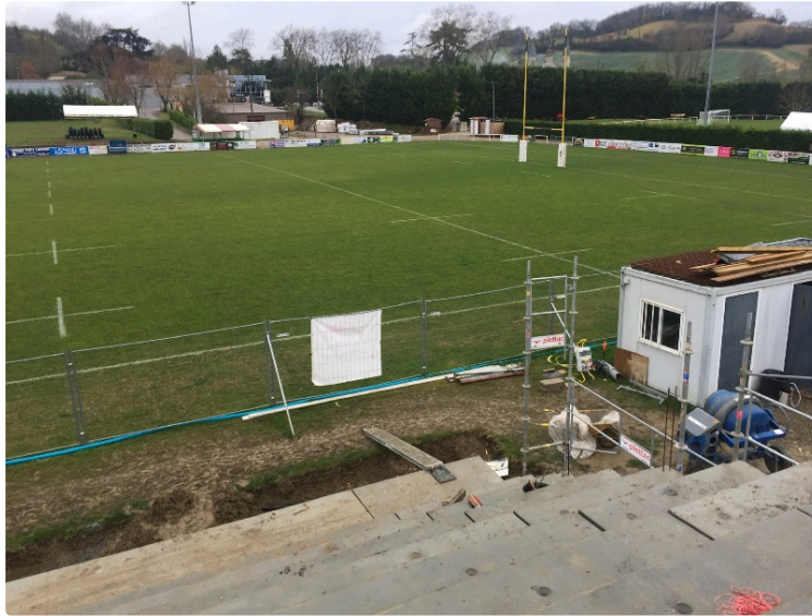
Tribunes de rugby : les travaux avancent
