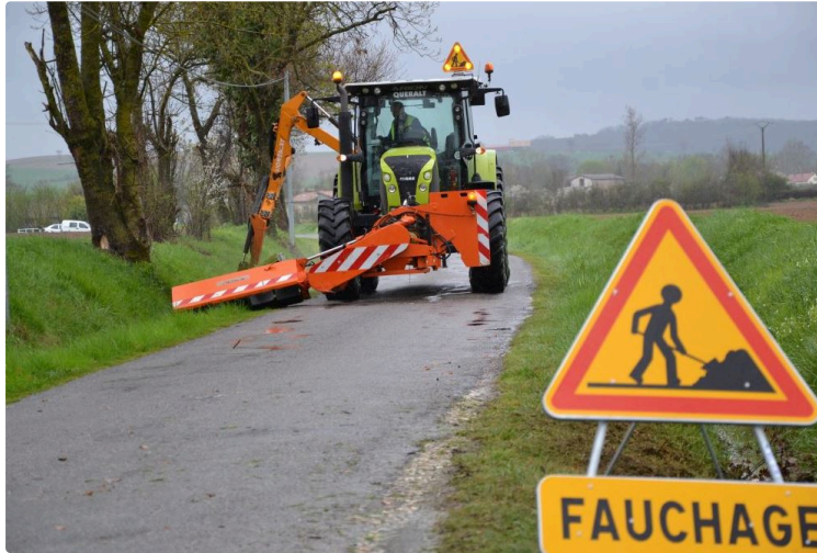
Reprise des travaux d'entretien des routes départementales
