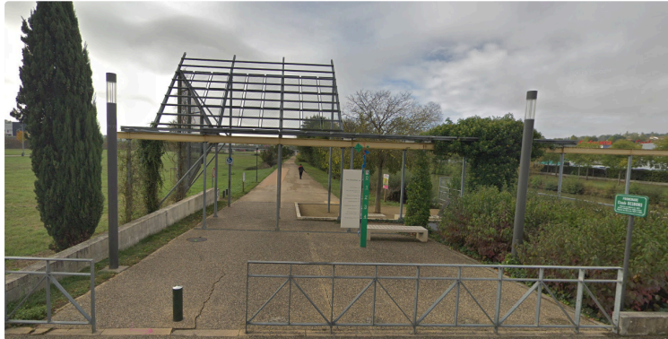
Réfection de la promenade Claude Desbons
