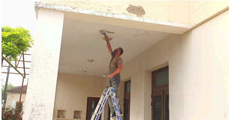
Les travaux de peinture démarrent à la salle des fêtes
