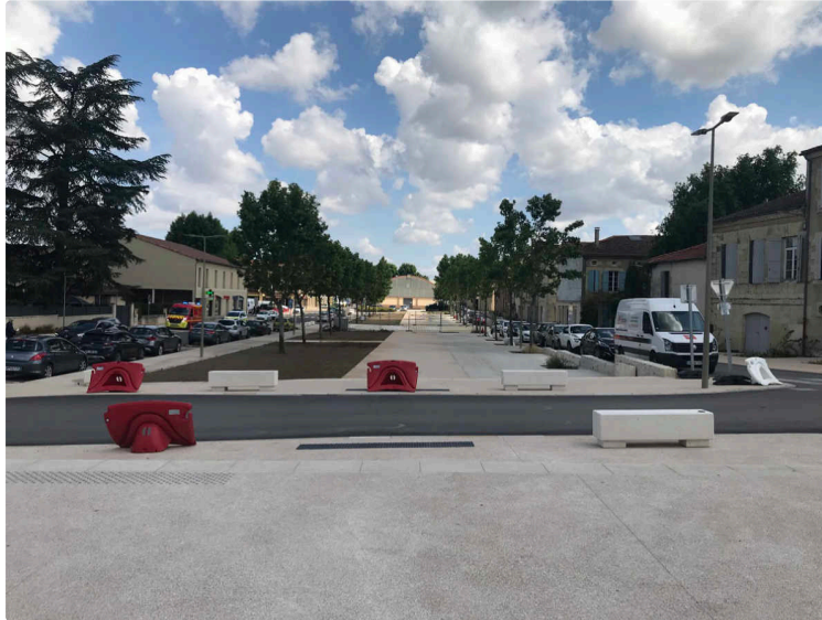
Travaux du Marcadet : dernière phase !
