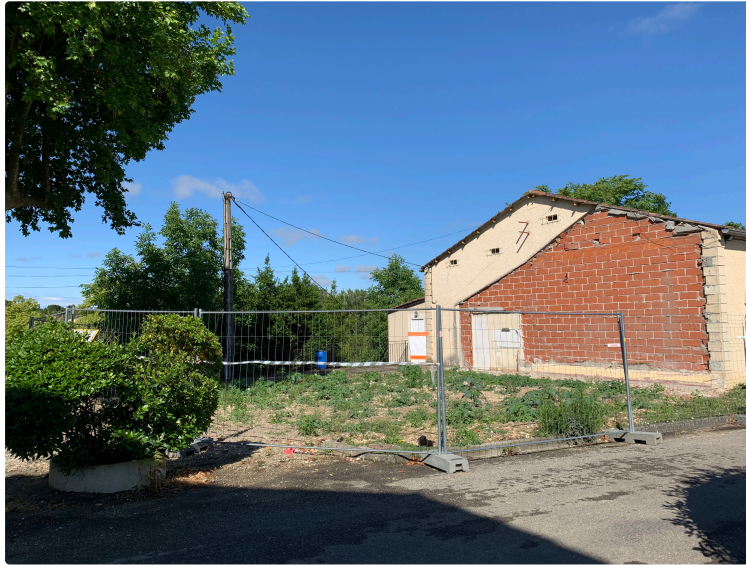
Travaux pour la Maison de Santé
