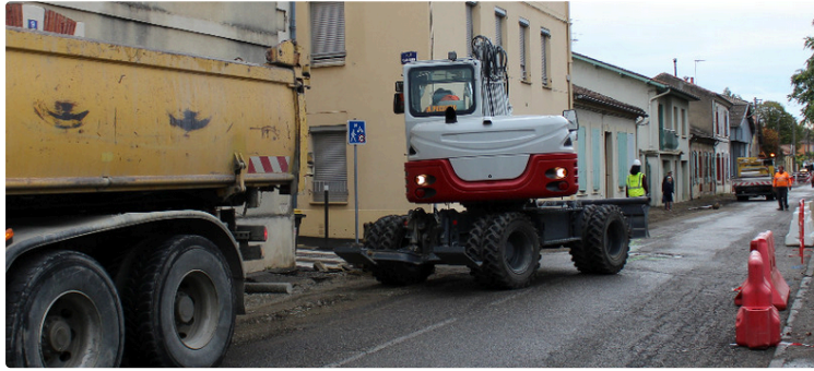
Avenue Sambre et Meuse : réouverture à la circulation le 1er septembre
