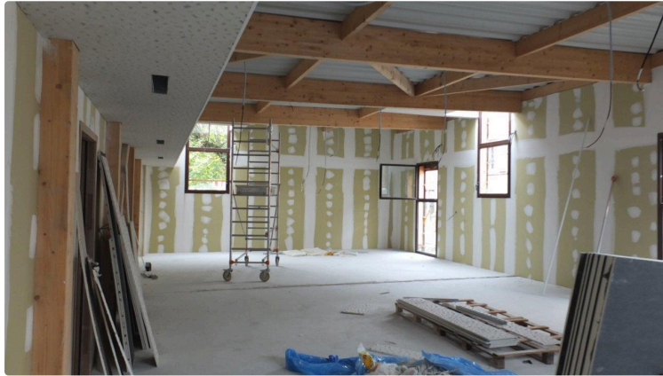
Les travaux de la future école maternelle avancent
