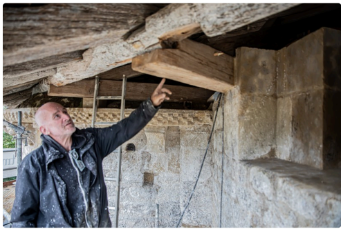
Cyrille Fourest montre la charpente rénovée
