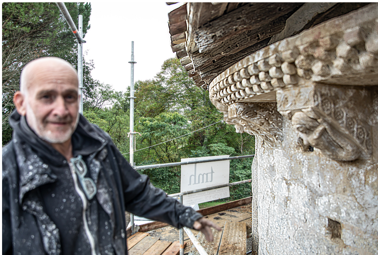
L'église de Croûte à Lasserrade restaurée par TMH
