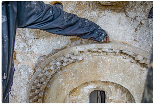
Cyrille Fourest montre une liaison ancien-rénové
