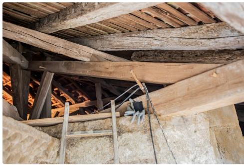
Aspect actuel de la charpente
