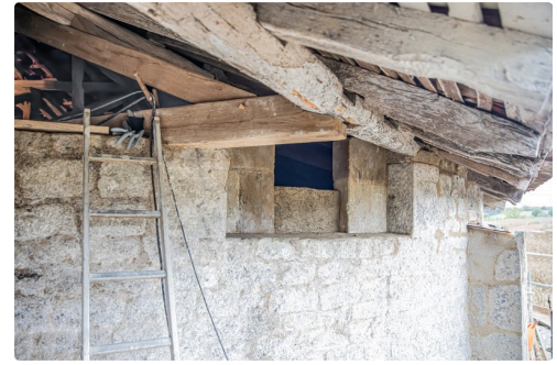
Une vue de la charpente restaurée
