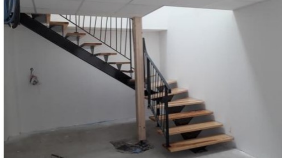
LG soudure-metallerie : des créations sur mesure
