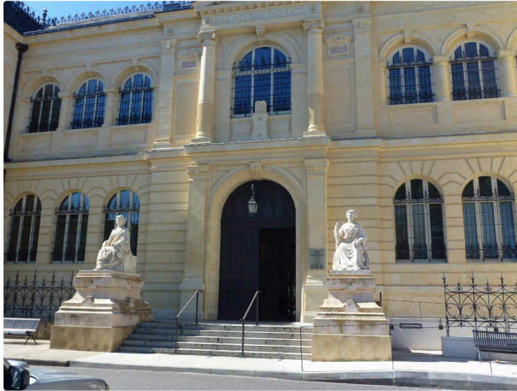
France Relance : la rénovation énergétique des bâtiments de l'État
