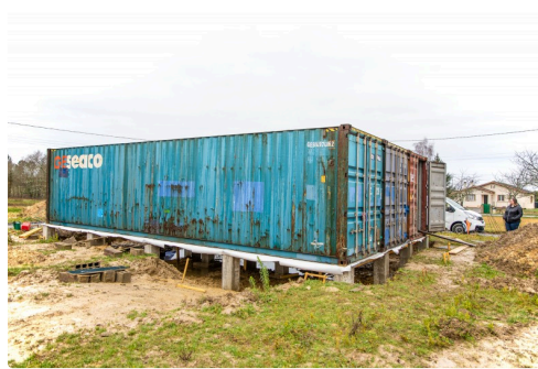
Le chantier sous un autre angle
