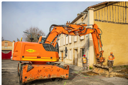
Travaux de terrassement aux arènes
