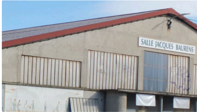
Le choix de l'entreprise a été validé pour les travaux Salle J. Baurens
