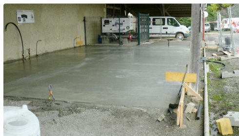
La dalle en béton fraîchement coulée.
