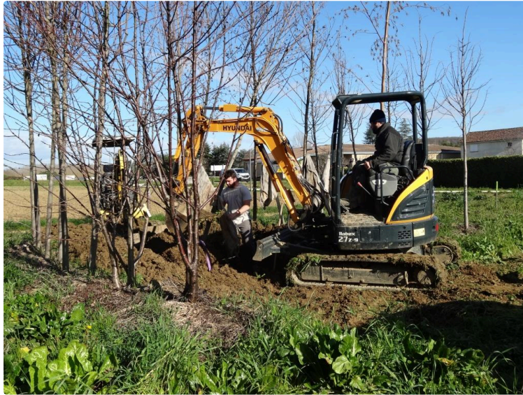
Reprise des travaux d'aménagement paysager de l'entrée Nord et de l'esplanade des salles
