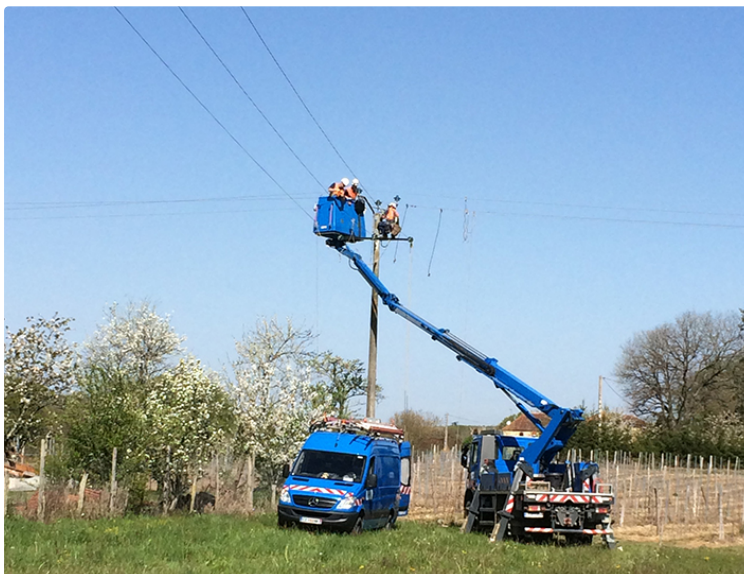
ENEDIS fiabilise son réseau électriqueENEDIS rénove le réseau 20 000V au sud de Mirande
