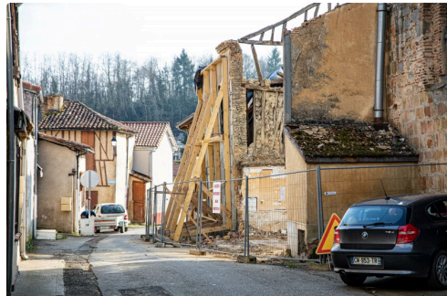
Le chantier n'est pas terminé
