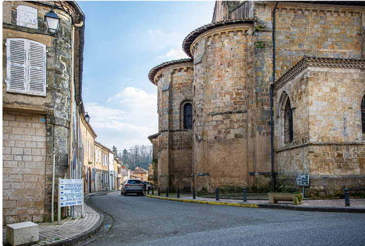
Réouverture de la rue des Pénitents à Nogaro
