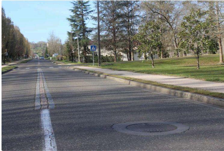
Réfection de chaussée sur la RN 524
