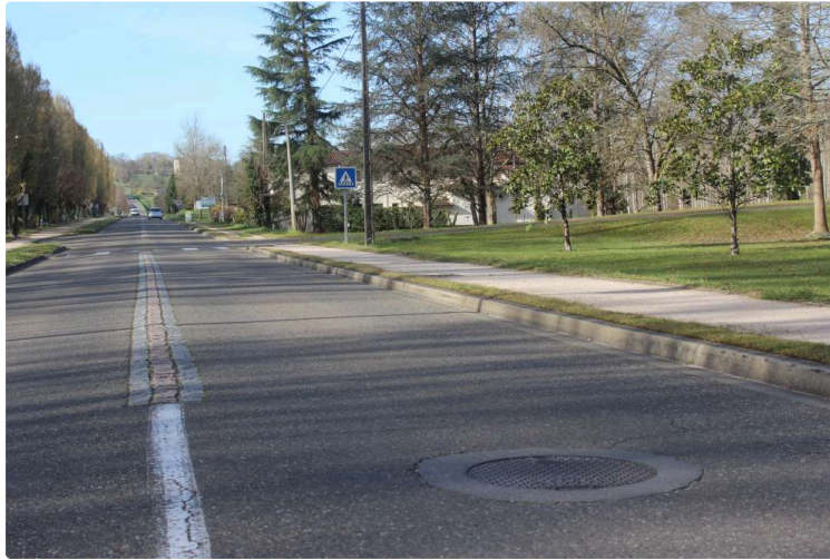
Réfection de chaussée sur la RN 524
